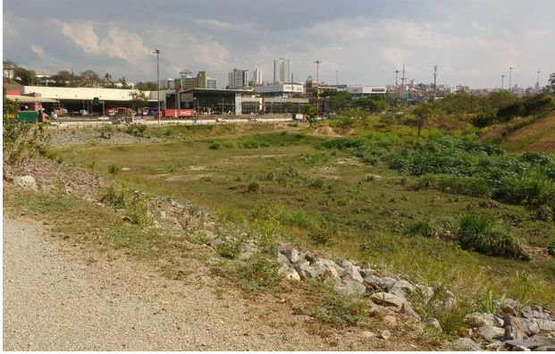
Figure 2. Detention basin of Córrego Engenho Nogueira.
